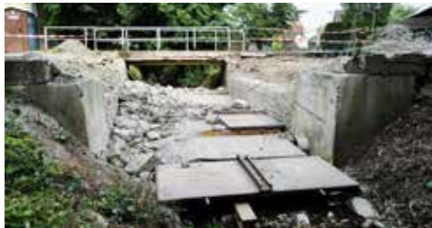
Abb. 3: Der Abriss der Brücke in der Brückenstraße im Juli 2022
