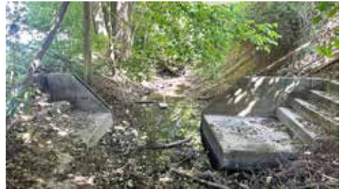
Abb. 8: Das Stauwehr kurz vor der Kleebachbrücke in der Brückenstraße
