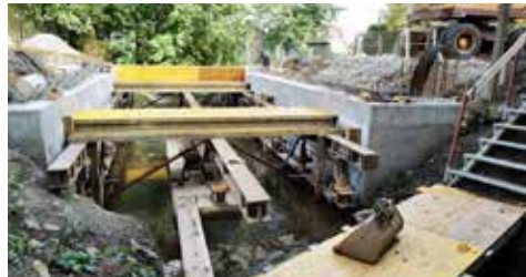
Abb. 4: Brückenneubau im September 2022
