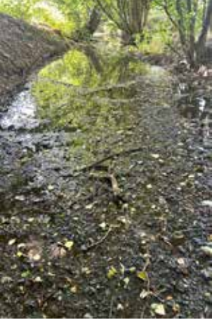
Abb. 7: Der Kleebach ist im Bereich der Kleebachbrücke in der Brückenstraße nur noch ein kleines Rinnsal
